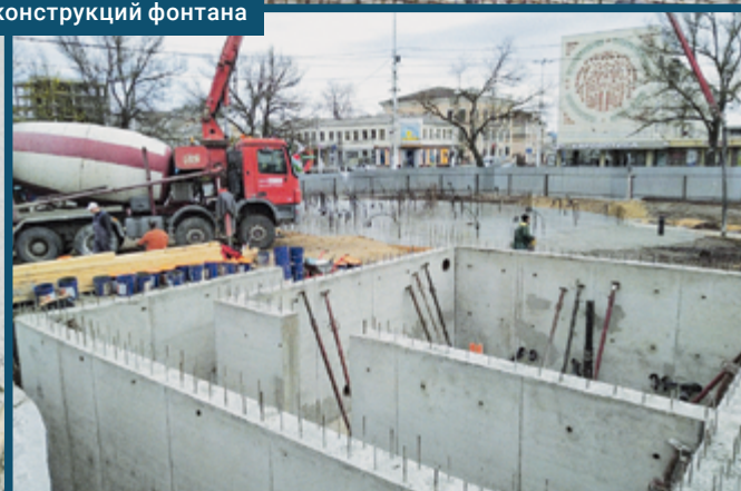
Заливка бетонных конструкций фонтана
