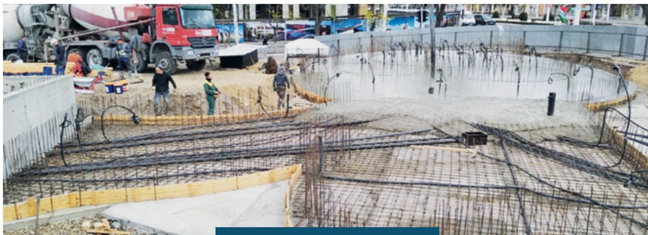
Заливка бетонных конструкций фонтана
