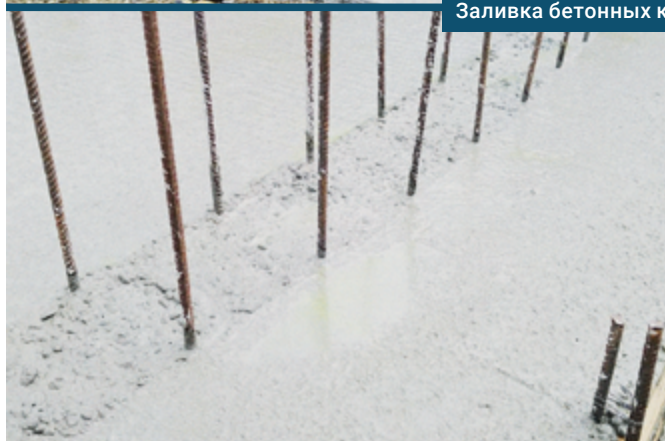
Заливка бетонных конструкций фонтана
